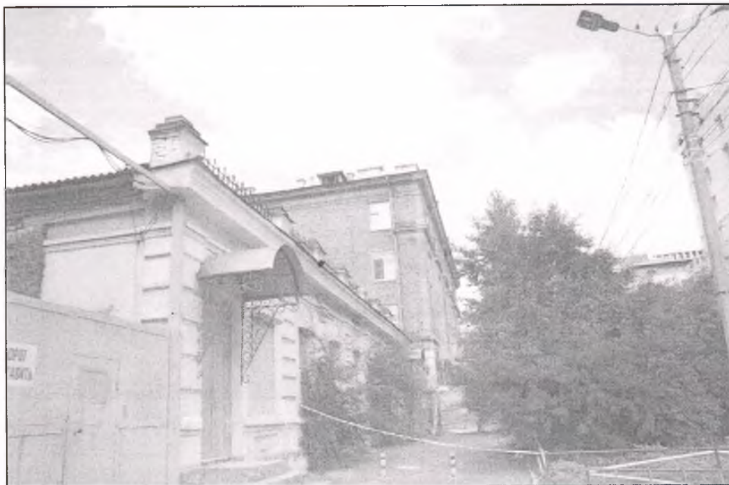
Фото 1. Главный юго-восточный фасад. Вид с юго-запада.
